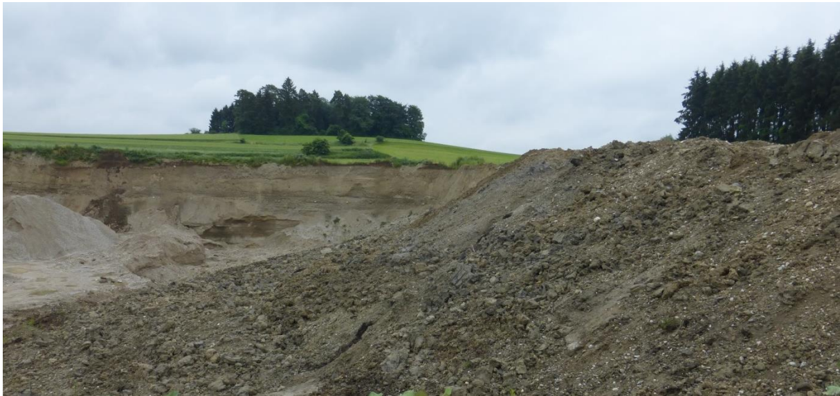
Auffüllungsarbeiten nach dem Abbaufortschritt.
