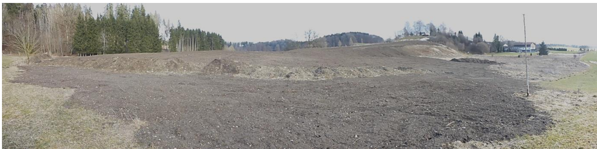
Die Geländeform wird wieder hergestellt.
